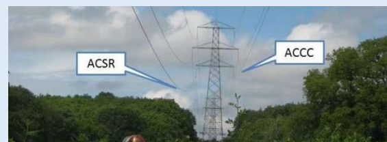
Fig.2 – Hagományos ACSR és egy magas hőmérsékletű alacsony belógású ACCC sodrony belógás összehasonlítása [2]
